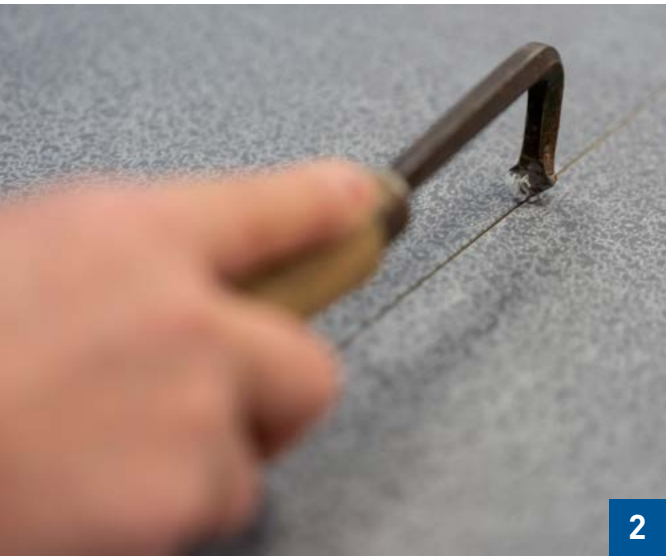
Drážkování před svařováním
